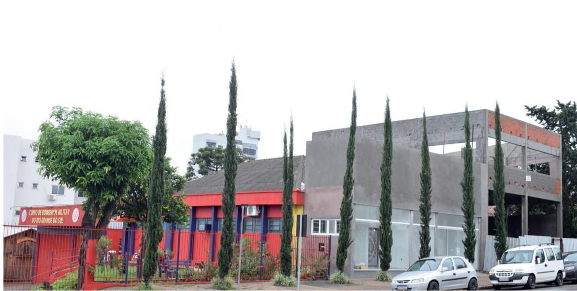
Corporação tenta finalizar obras de ampliação
